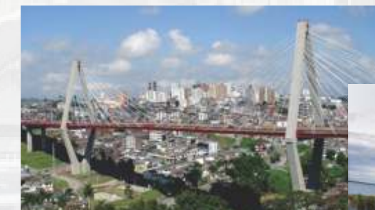
El viaducto César Gaviria Trujillo
